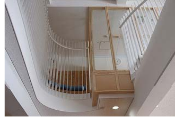
・吹き抜けに突き出している放送室
