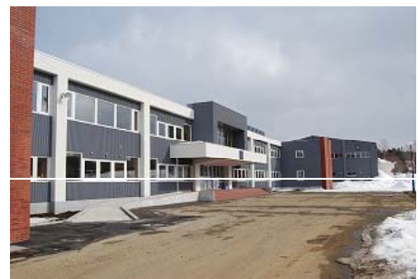
■改修工事完了時全景
