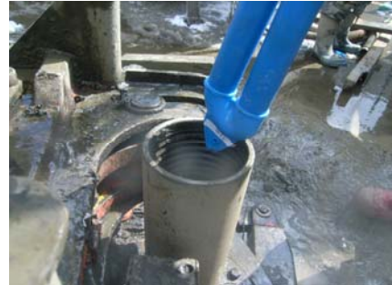
人力による 採熱管の挿入
