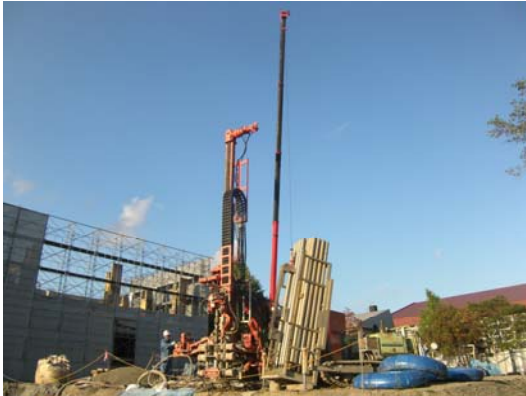
地中熱交換器設置工事
