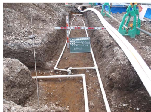
設置後の接続・配管
